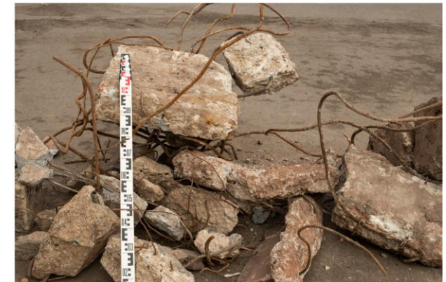
Beton mit Armierung
