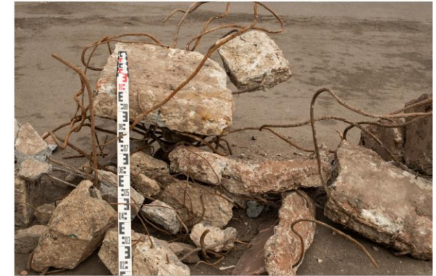
Beton mit Armierung
