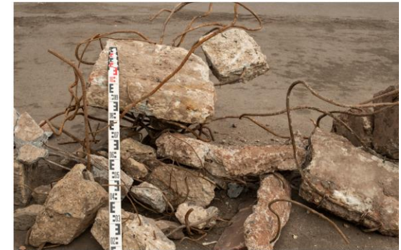
Beton mit Armierung
